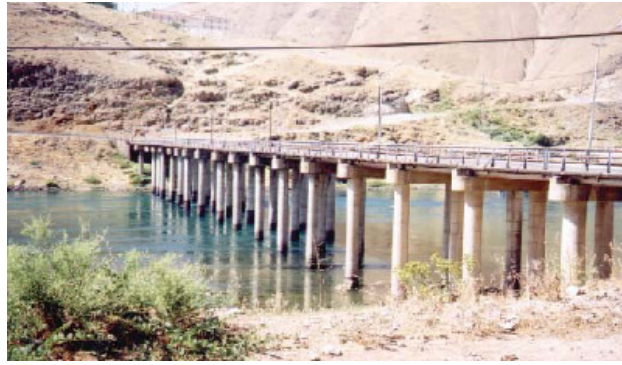
Şekil 5.19: Görüntülerde Kolaylıkla Tespit Edilebilen Beton Köprü Detayı
