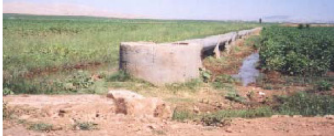
Şekil 5.16: Su Detaylarından Kanalet ve Su Sifonunun Görüntüsü
