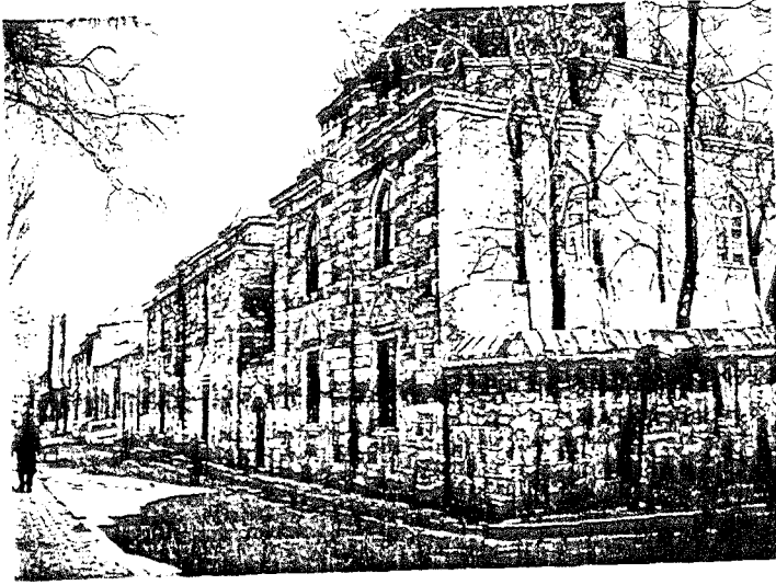
Şekil 6.15. Şehzade Külliyesinin İmareti (Fotoğraf: D.Kuban)
