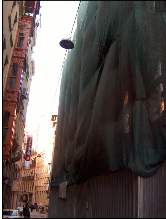
Şekil C.2: Kamondo Han'ın Restorasyon Çalışmalarından Görünüş
