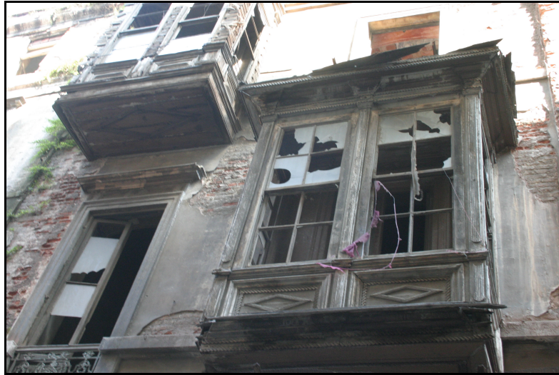
Şekil B.2: Kamondo Han'ın Ön Cephesinden Görünüş
