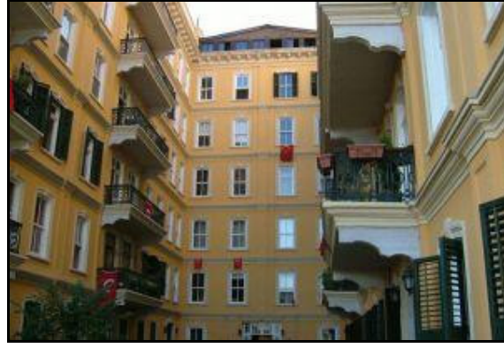
Şekil 5.8: Doğan Apartmanının Avlusundan Görünüş
