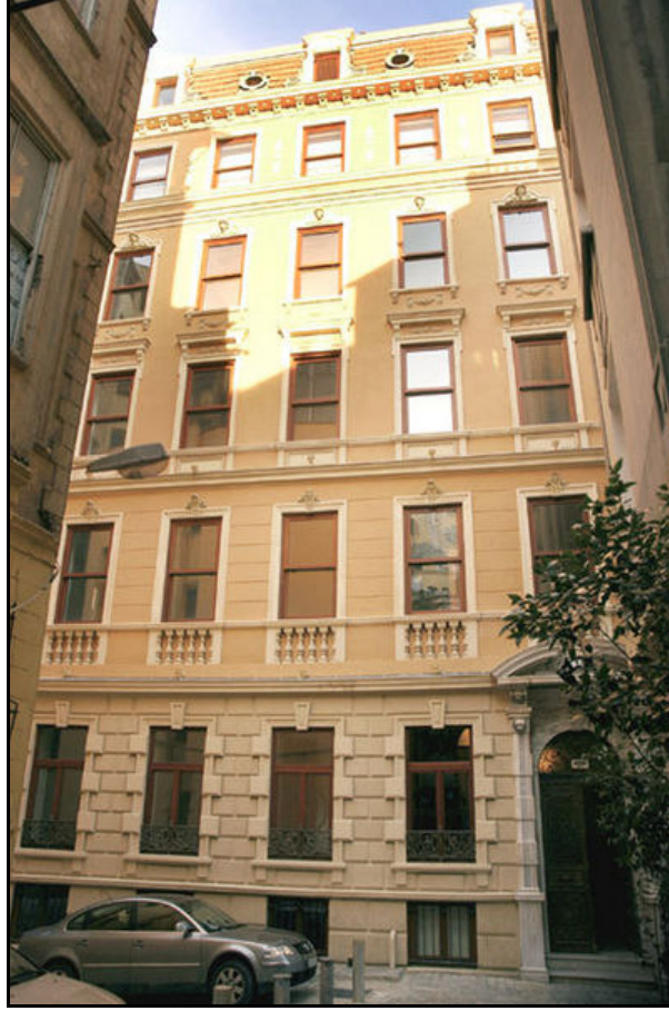
Şekil 5.7: Rizzo Apartmanından Genel Görünüş
