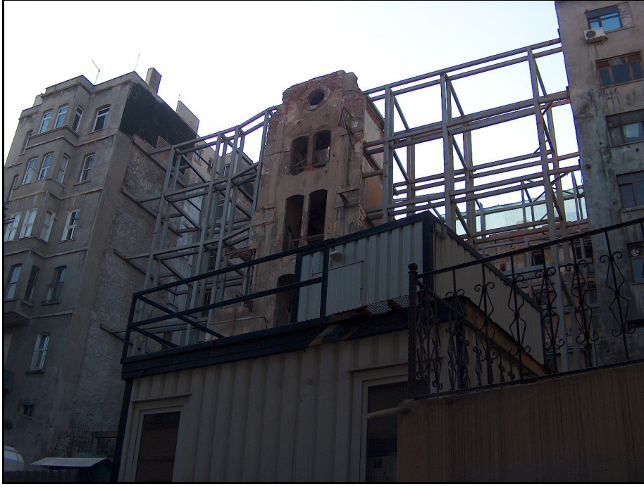
Şekil C.1: Kamondo Han'ın Restorasyon Çalışmalarından Görünüş
