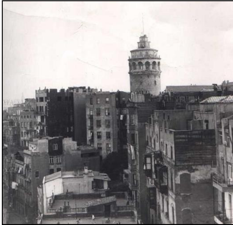
Şekil 5.5: Kamondo Han'ın Güneydoğu Cephesinden Görünüş
