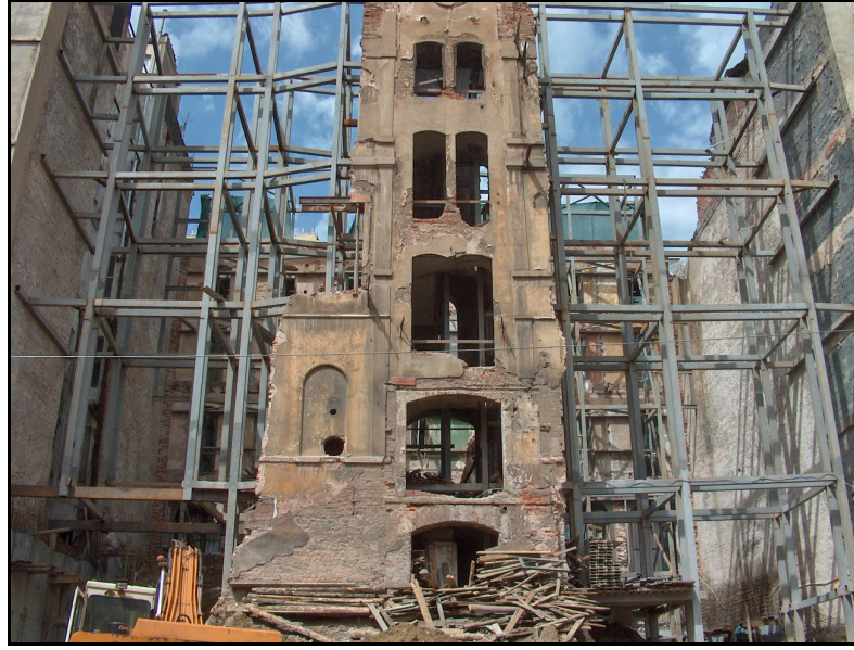
Şekil 5.6: Kamondo Han'ın Restorasyon Çalışmalarından Görünüş
