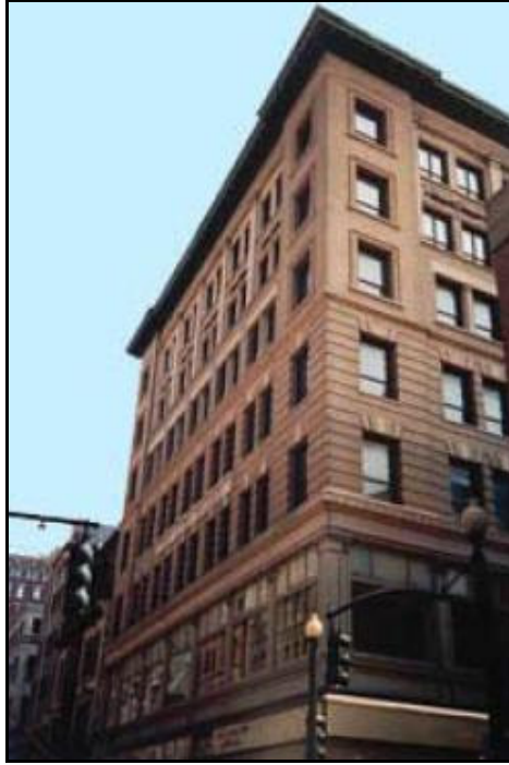
Şekil 3.6: Alice Binasından Genel Görünüş
