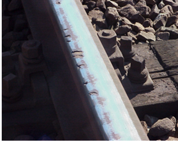
Şekil 4.4 : İç köşe kabuklanması.
