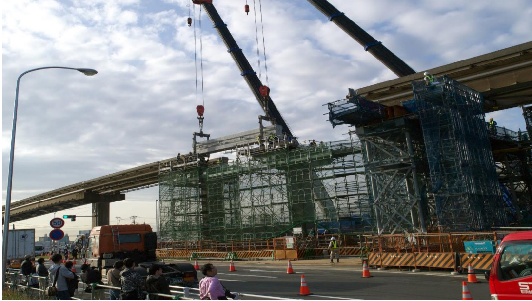
Şekil 4.13 : Öngerilmeli ray kirişinin yerleştirilmesi.
