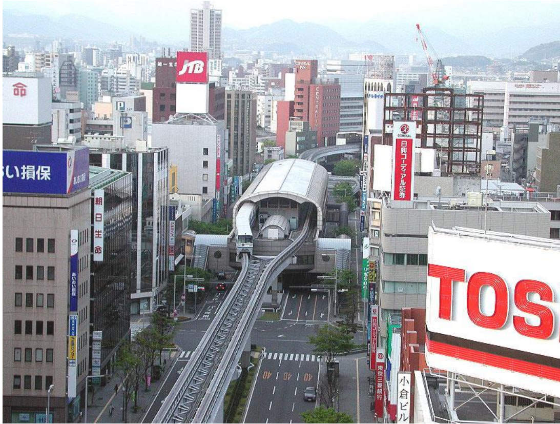
Şekil 4.8 : Ada platformlu istasyon.
