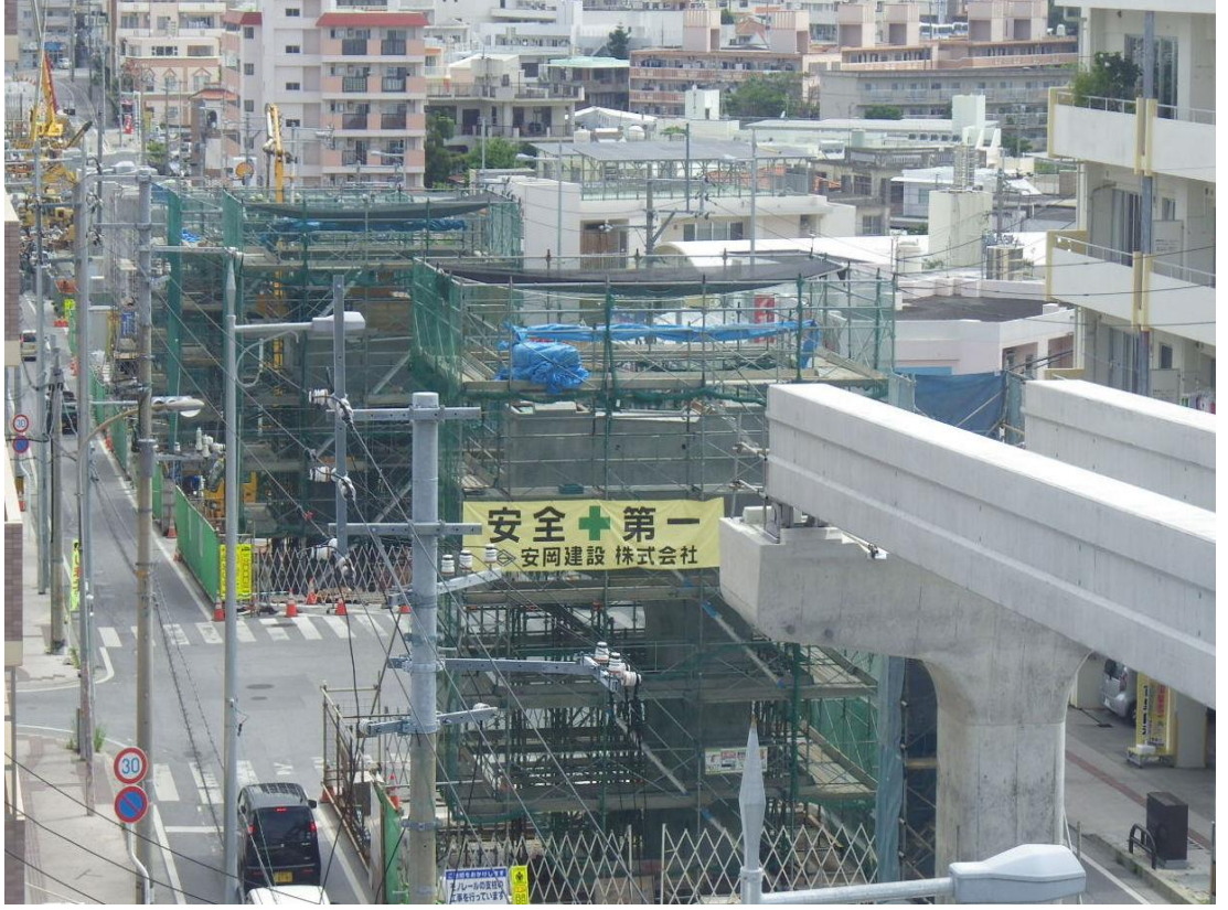
Şekil 4.15 : İstasyon inşaatını gösteren çalışma-1.
