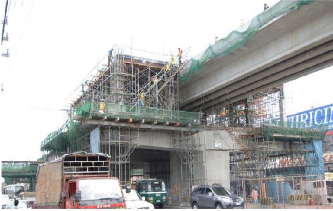
Şekil 4.17 : İstasyon inşaatını gösteren çalışma-3.
