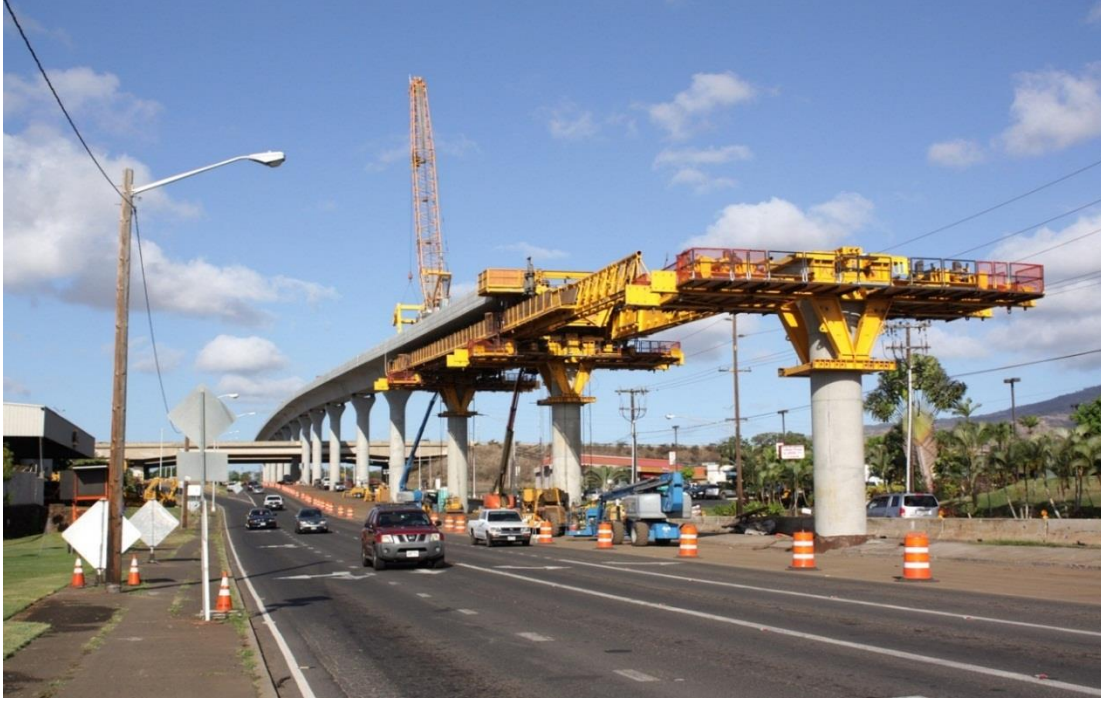
Şekil 4.12 : Beton viyadük inşaaı-2.
