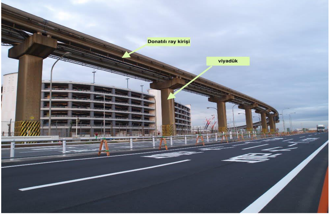
Şekil 4.2 : Tekil-tip temel ayağına sahip öngerilmeli kiriş.
