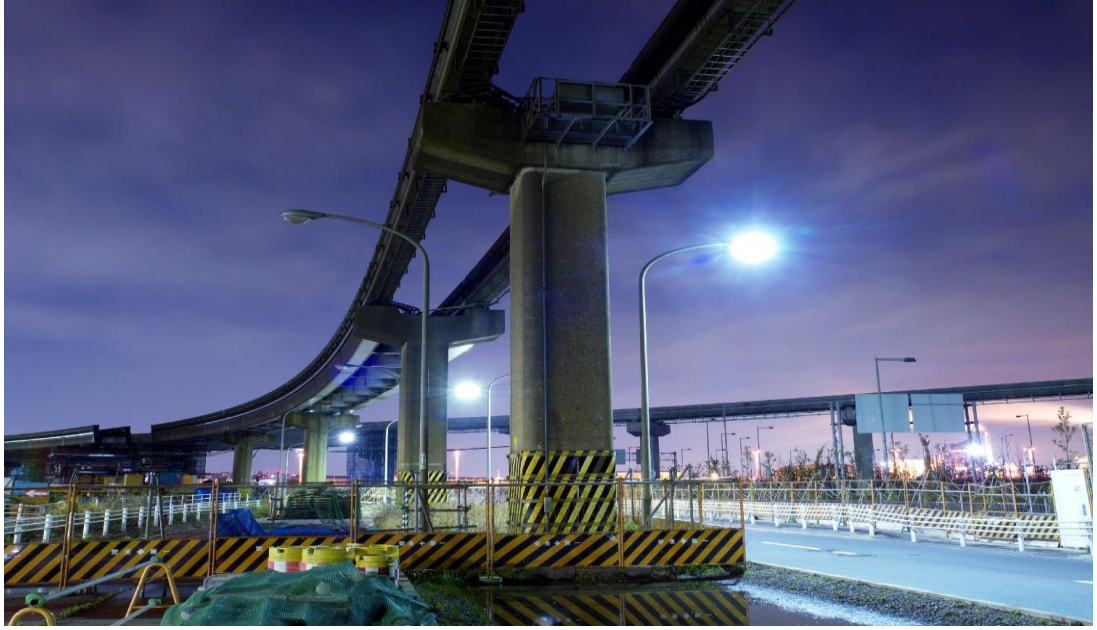
Şekil 4.10 : Monoray inşaat çalışma alanı.
