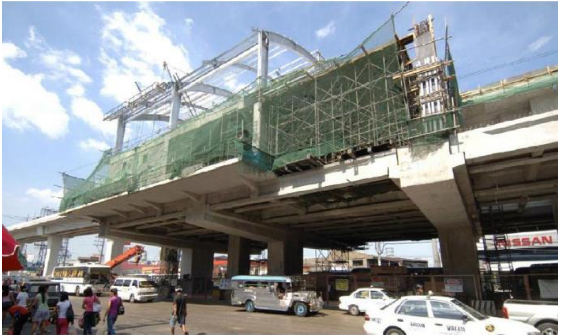
Şekil 4.16 : İstasyon inşaatını gösteren çalışma-2.
