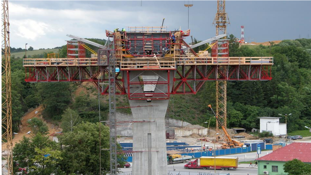
Şekil 4.11 : Betonarme viyadük inşası-1
