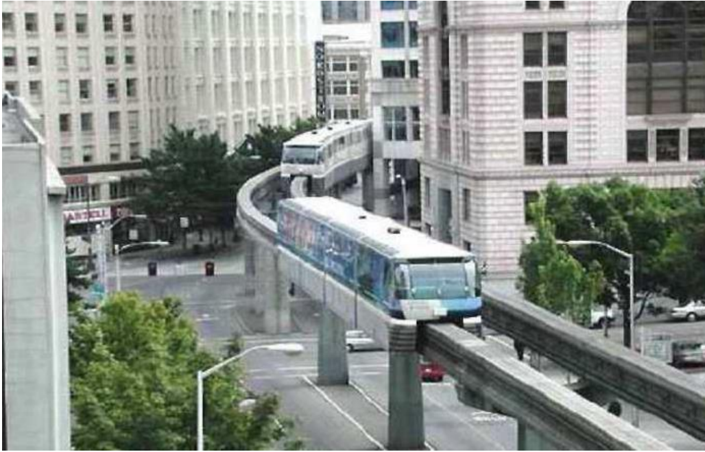
Şekil 3.4 : Bindirme tip monoray örneği (Kennedy, 2007).
