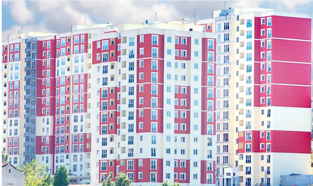
Şekil 4.36 : 1452 ada 37 parselde inşa edilen konutlar. (GOP Faaliyet Raporu, 2015)
