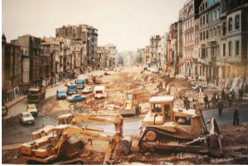
Şekil 3.15 : Tarlabası Bulvarı'nın inşaatı. (Birik, 2011)
