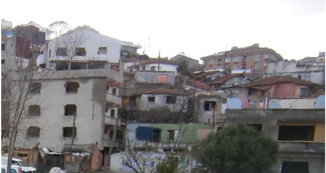
Şekil 4.47: Alanda boşaltılmış yıkımı bekleyen konutlar.
