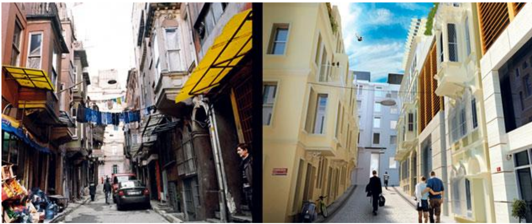
Şekil 3.17 : Tarlabası yenileme projesi öncesinde/sonrasında oluşan sokak yapısı. (GAP İnşaat)
