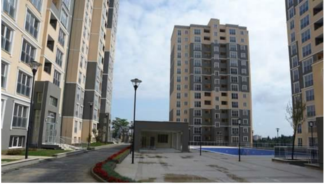
Şekil 4.35 : 1452 ada 34 parselde inşa edilen konutlar. (GOP Faaliyet Raporu, 2015)
