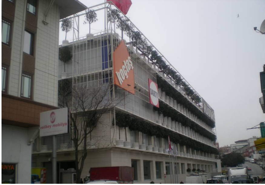
Şekil 5.28 : Flatofis Ofis Binası.
