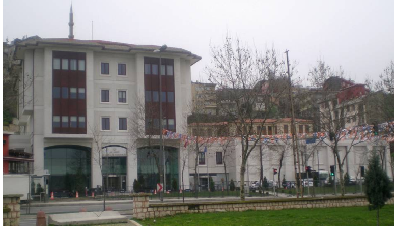
Şekil 5.21 : AKP İstanbul İl Başkanlığı Binası.
