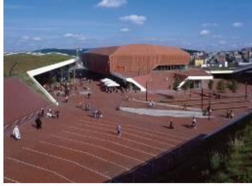
Şekil 4.10 : Cephe ve yer döşemeleri
