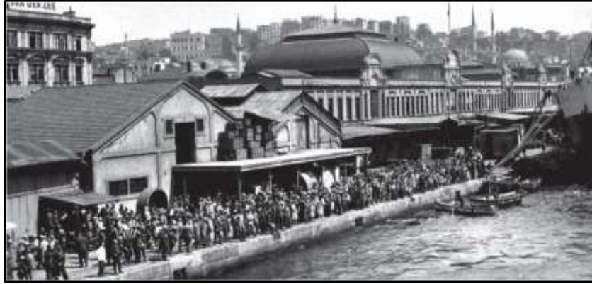
Şekil 3.15 : Galata Gümrük Binası fotoğrafı (Url-2).
