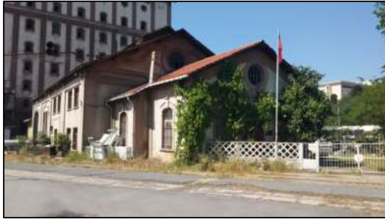
Şekil 4.12 : Elektrik Santrali ve arkasında Silo B (Bilgili, 2016).
