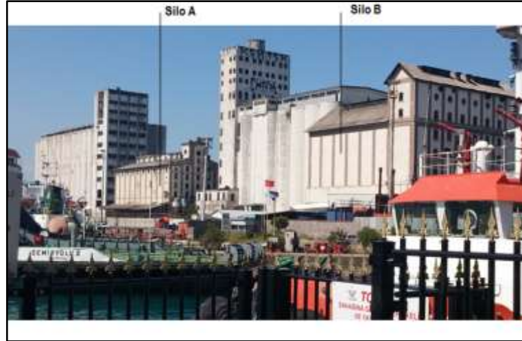
Şekil 4.8 : Silo A ve Silo B (Bilgili, 2016).
