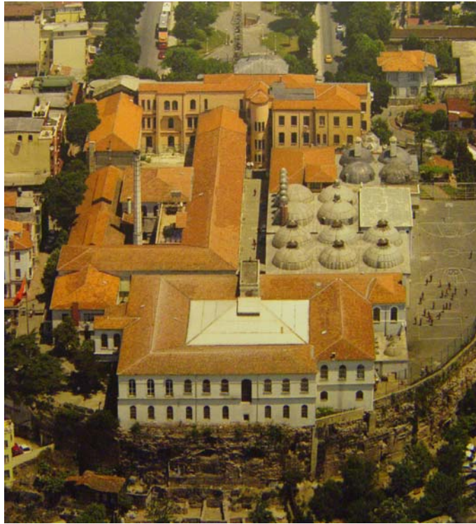
řekil 4.15: Sultanahmet Meslek ve Marmara niversitesi Rektrlk Binası (Kaynak: Payitahtı Zemin Eminn Bir Dnya Bařkenti.)
