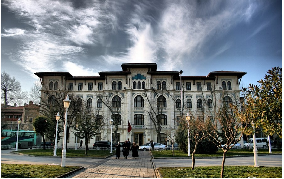
Şekil 4.6: Tapu ve Kadastro Binası (Kaynak: wowturkey internet sitesi)
