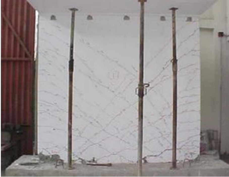
Şekil 2.5 : MFIEN3EP numunesinde oluşan çapraz gövde çatlakları [Quiroz ve diğ. (2013)]
