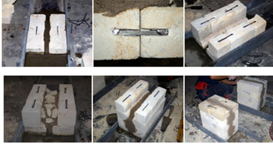
Şekil 2.1 : Şekil. Çok tabakalı duvarın yapım aşamaları (Demir, 2012)
