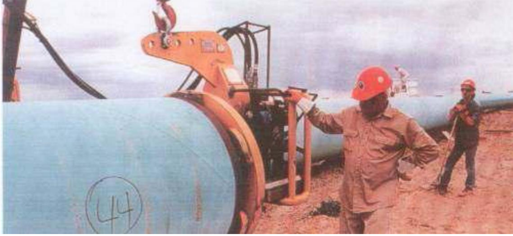
Şekil 2.5 : Otomatik boru hattı ağızlama makinesi [40].
