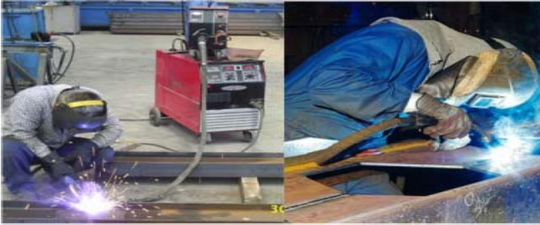
Şekil 3.3 : MIG kaynağı uygulamaları [11].
