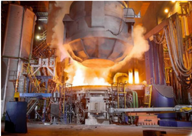
Şekil 3. 2: Elektrik Ark Fırını.
