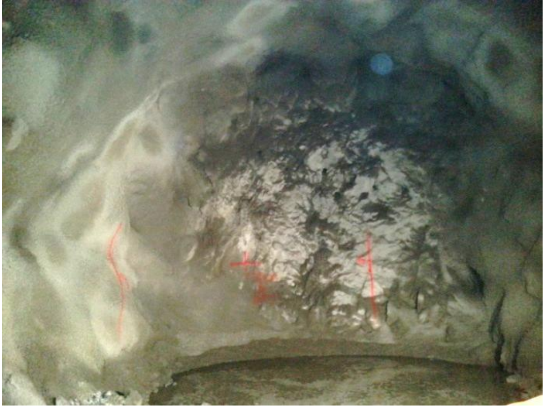
Şekil 6.9: Püskürtme beton uygulanmış bir üretim aynası.
