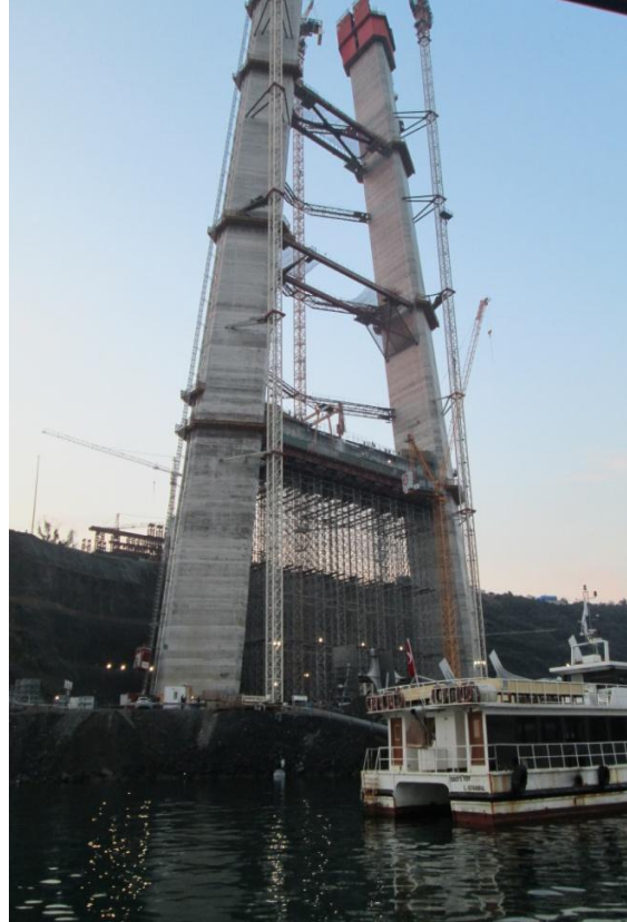
Şekil 5.3: Üçüncü Boğaz Köprüsü inşaatından bir görünüm (Garipçe, 2014).
