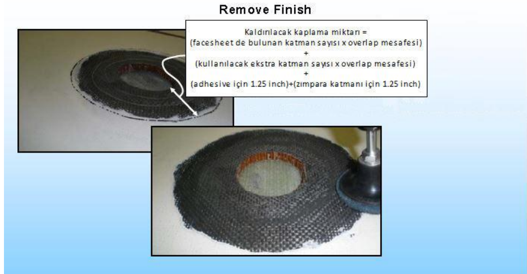
Şekil 3.9 : Yüzeydeki koruyucu katmanın kaldırılması.
