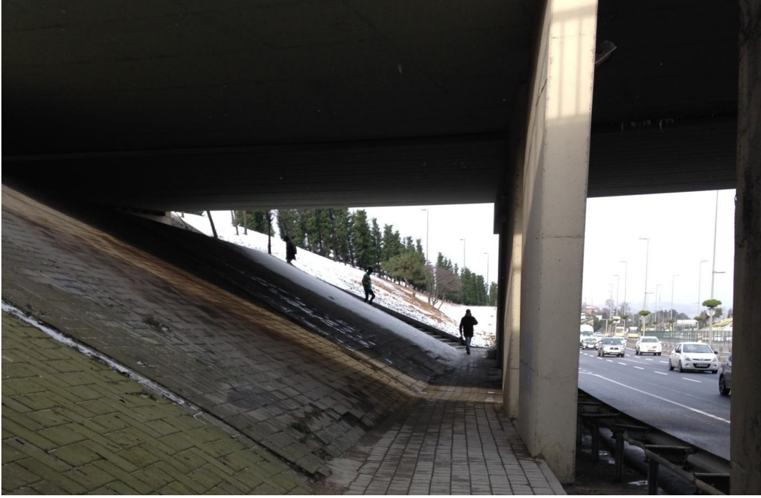
Şekil 2.1.1.1.3 : İnşa edilen merdiven ve kaldırım (Eda Özgener arşivi).
