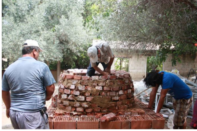
Şekil 4.9 : Fırının yapımı (Url-6).
