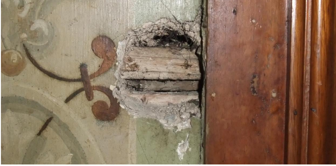
Şekil 3.7 : Gezeryan Köşkü – Ahşap karkas duvarlar (Gökçınar, 2014).
