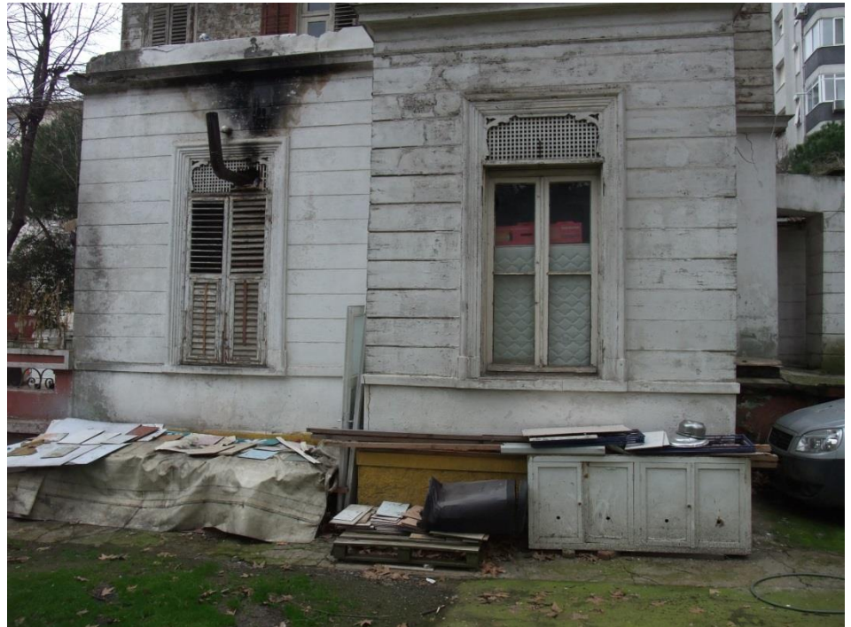
Şekil B.2.10 (Gezeryan Köşkü güneydoğu cephesi) (Gökçınar, 2014)
