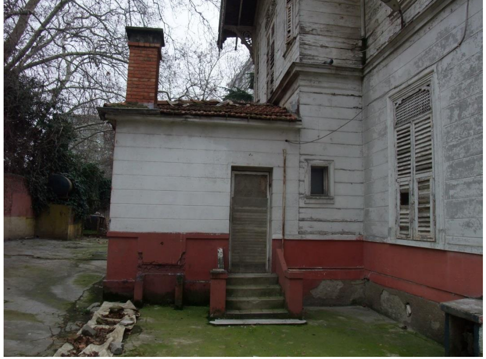
Şekil B.2.5 (Gezeryan Köşkü kuzeybatı cephesi) (Gökçınar, 2014)
