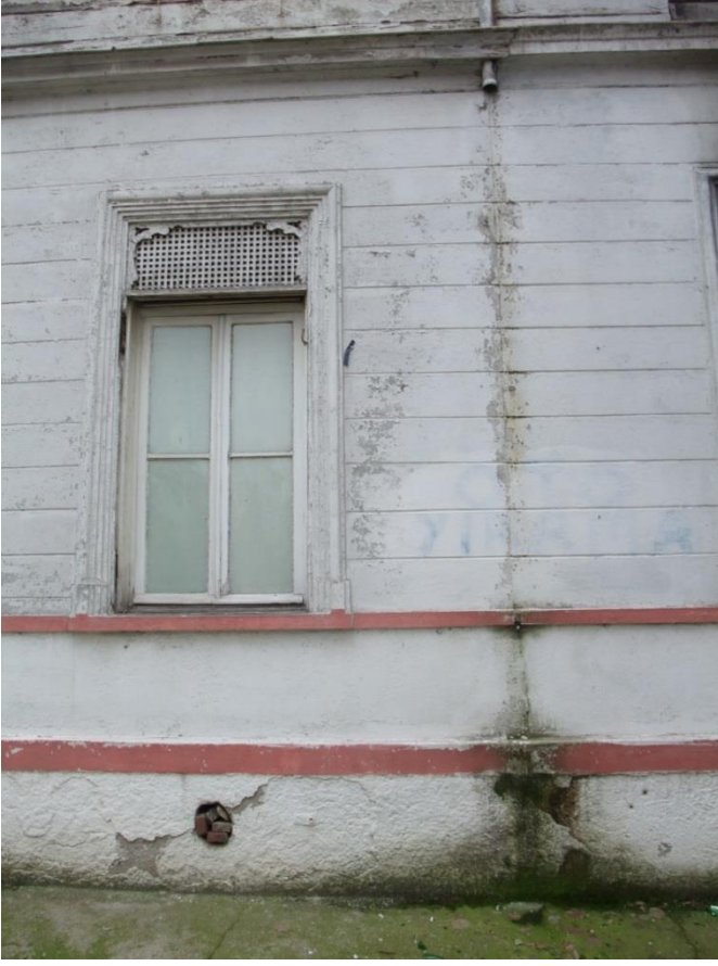
Şekil B.2.3(Gezeryan Köşkü kuzeybatı cephesi) (Gökçınar, 2014)
