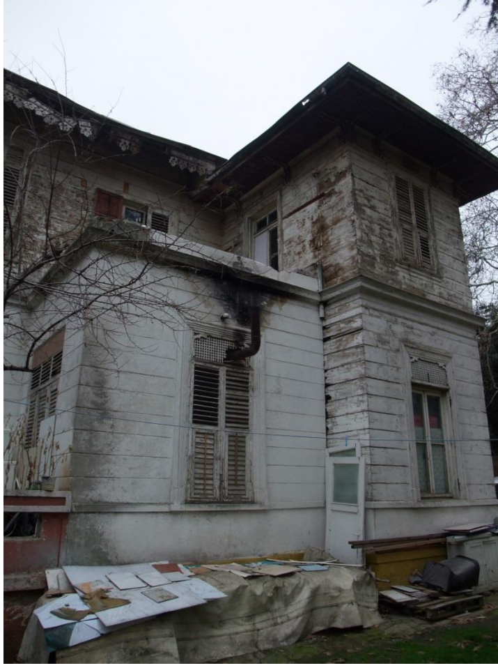
Şekil B.2.11 (Gezeryan Köşkü güneydoğu cephesi) (Gökçınar, 2014)
