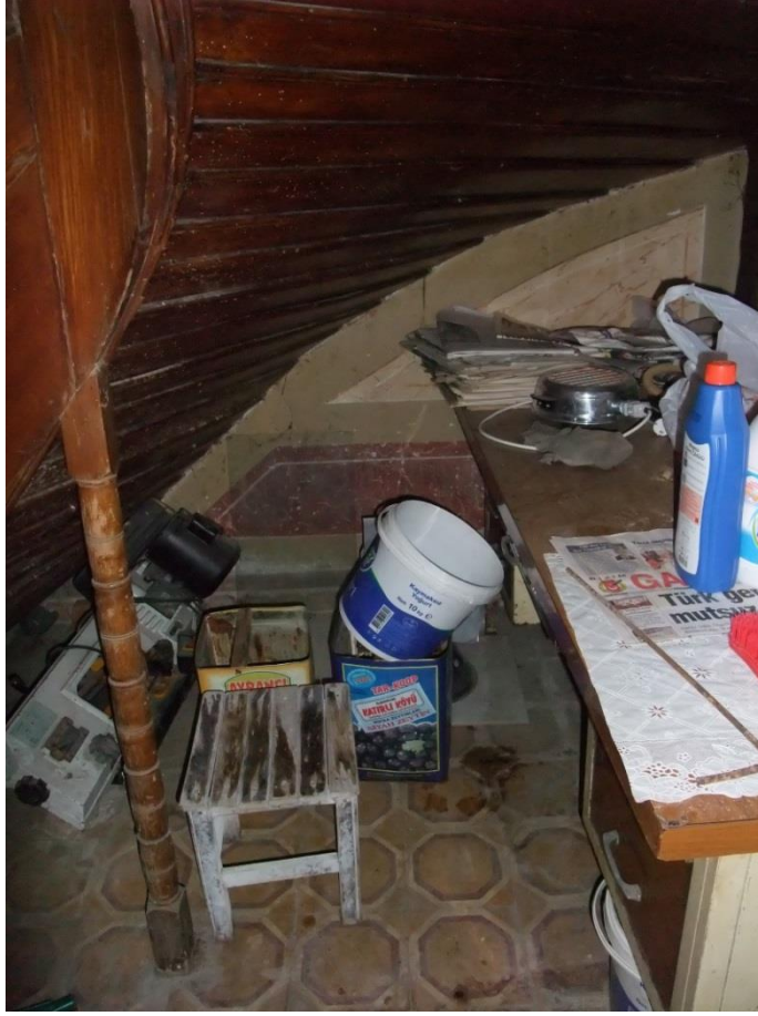
Şekil B.3.14 (Z03 mekanı – merdiven altı) (Gökçınar, 2014)
