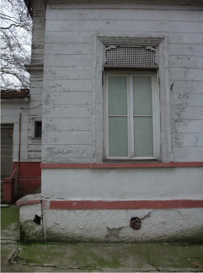
Şekil B.2.4 (Gezeryan Köşkü kuzeybatı cephesi) (Gökçınar, 2014)
