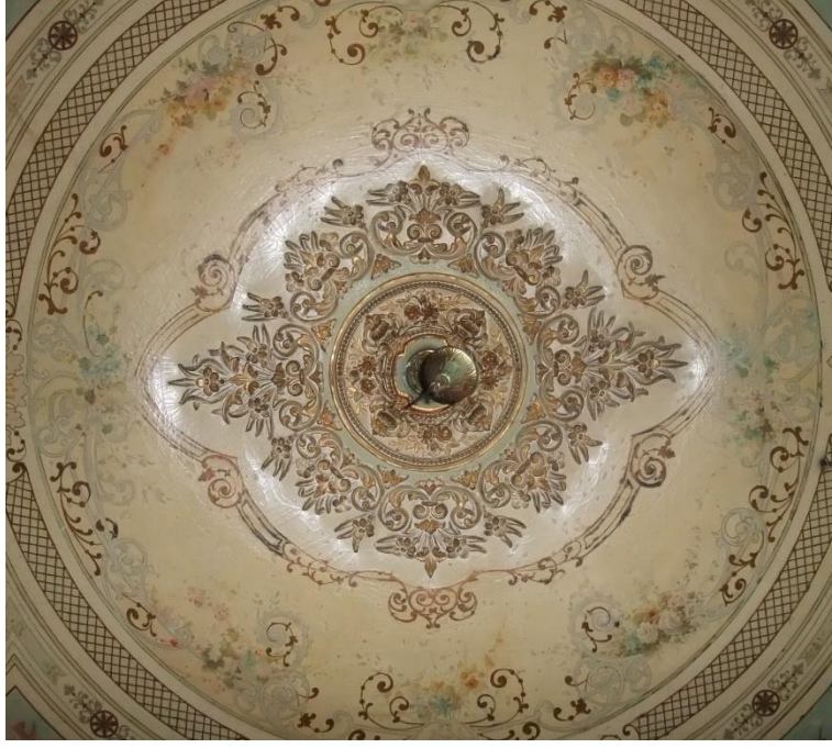
Şekil 3.9 : Kabartma bezemeler-tavan göbeği (102 mekanı) (Gökçınar, 2014).
