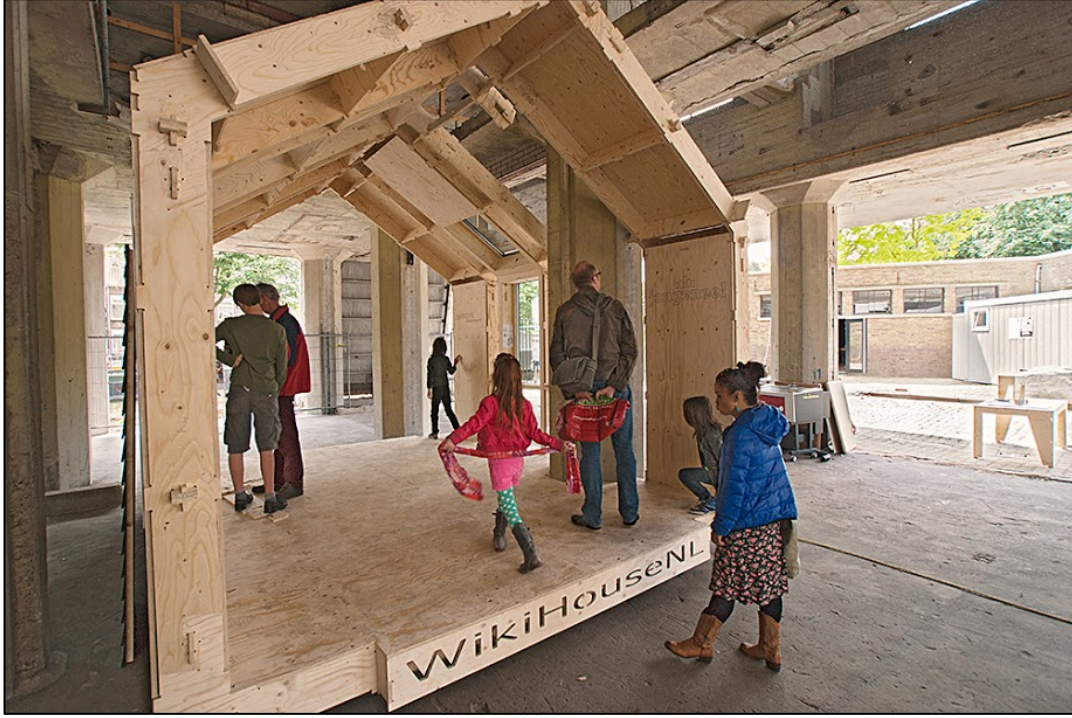
Şekil 2.11: Açık kaynak konstrüksiyon seti (WikiHouse, 2014).
