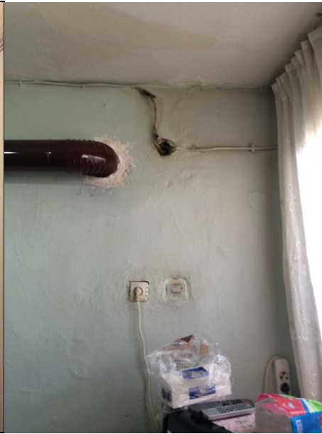
Şekil 4.31 : Ziyaret edilen bir konuttaki elektrik kablosunun tavandan sıva üstü yürüyüp körlenmeden sonlandığını gösteren resimler.
