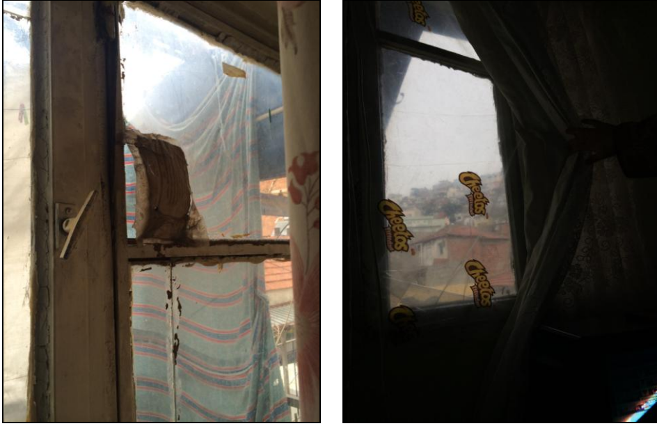
Şekil 4.38 : Ziyaret edilen konutlardaki ısı izolasyon zaafiyetini anlatan resimler.
