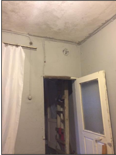
Şekil 4.31 : Ziyaret edilen bir konuttaki elektrik kablosunun tavandan sıva üstü yürüyüp körlenmeden sonlandığını gösteren resimler.
