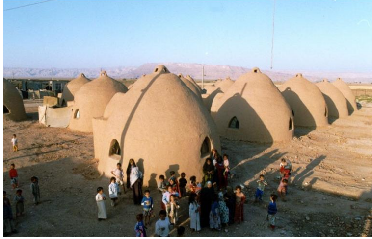
Şekil 3.5: İran Baninajar kampında sandbag barınağı kullanımı (Freij,2008).
