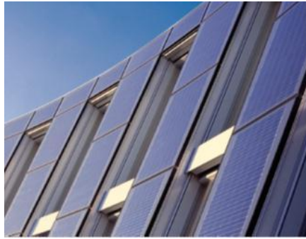
Şekil 3.21 : Cephe detaylarından gölgelenmeyen bir FV cephe örneği [58].
