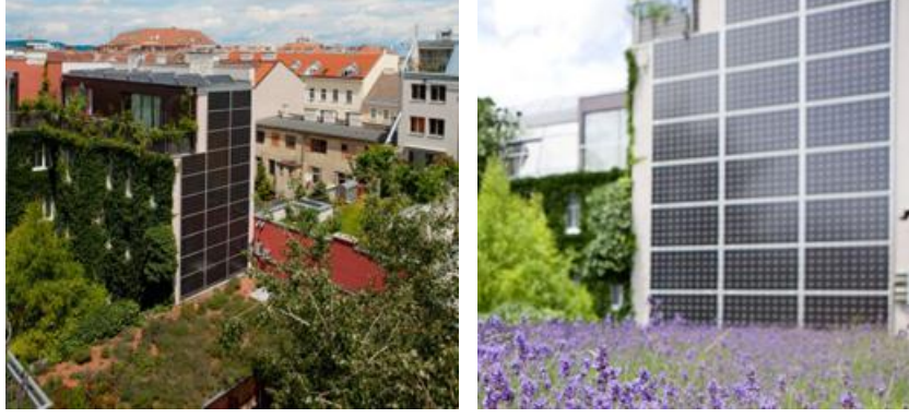
Şekil 4.3 : Viyana Stadthalle Butik Otel dış duvarına tespit edilen FV paneller [77].
