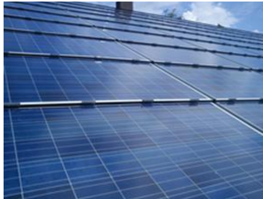
Şekil 4.5 : Eğimli çatıyla bütünleşik fotovoltaik paneller [79].
