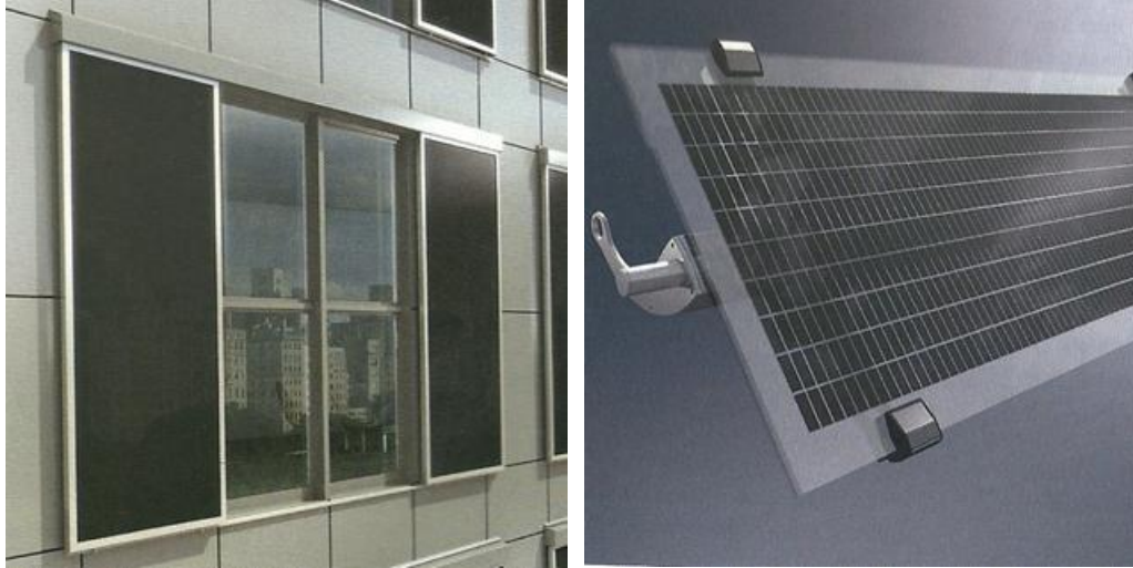
Şekil 4.2 : Dış duvara tespit edilen sürme panjur sistemli ve gölgeleme bileşeni olarak FV paneller [17].
