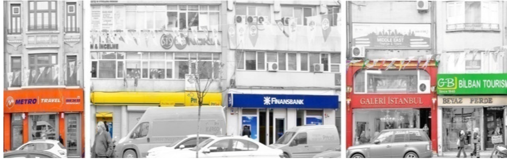
Şekil 5.1: Taksim – Maslak aksı üzerinde zemin kotta yer alan tabelalar ve yapıdan kopma
