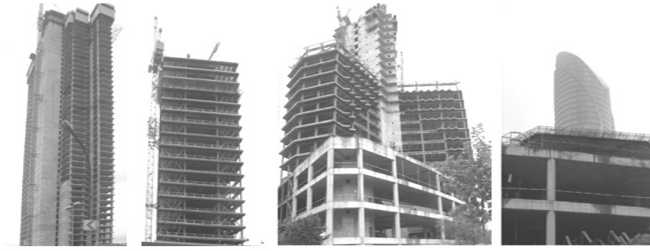
Şekil 5.6: Maslak bölgesinde yer alan şantiye çalışmaları
