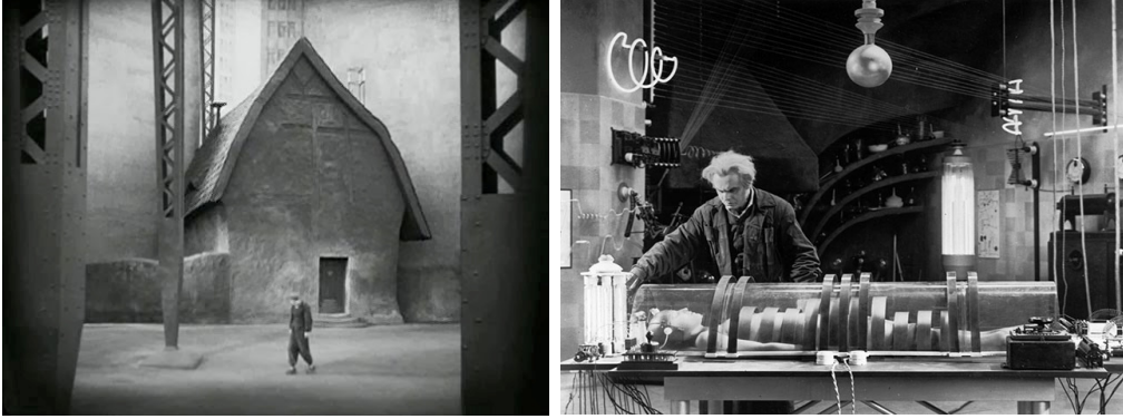
Şekil 4.9: Rotwang'ın evinin kent ile olan ilişkisi (sol), Rotwang'ın evi iç mekan (URL-11), (URL-12)
