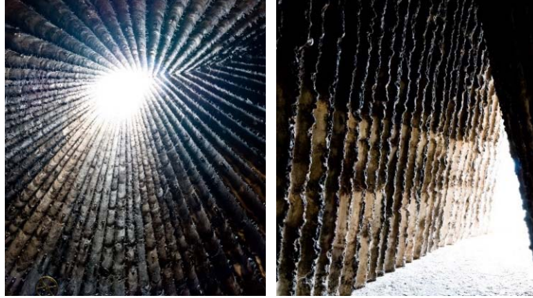
Şekil 4.20 : Şapelin iç mekanındaki yanmış ahşap malzeme (Url-24).
