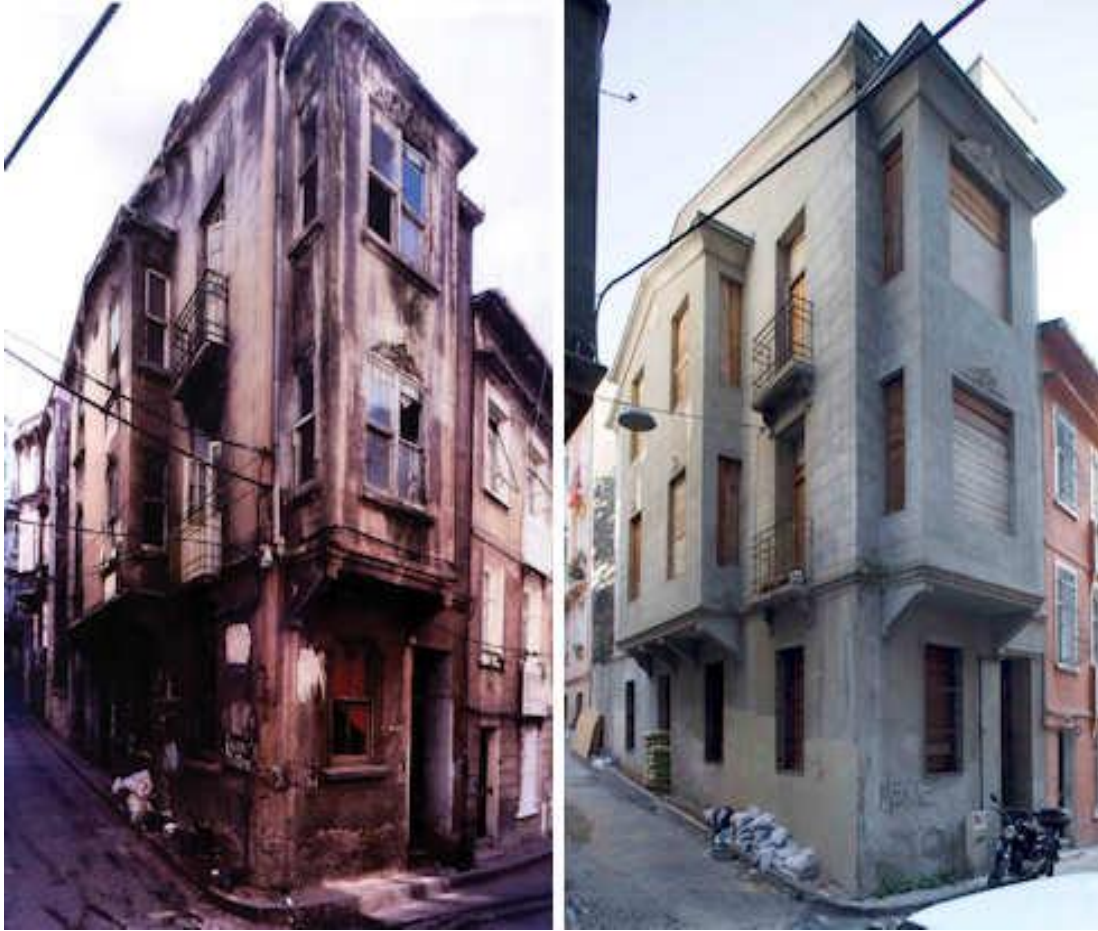
Şekil 4.18 : Brukner Apartmanı, 1999 – 2003, Fotoğraf: Cemal Emden (Url-13).
