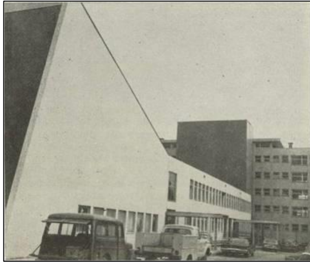
Şekil 3.26 : İstanbul Tıp Fakültesi Çapa yerleşkesinde Cerrahi Monoblok binasının ilk yapıldığı yıllardaki görünümü (Url-15).
