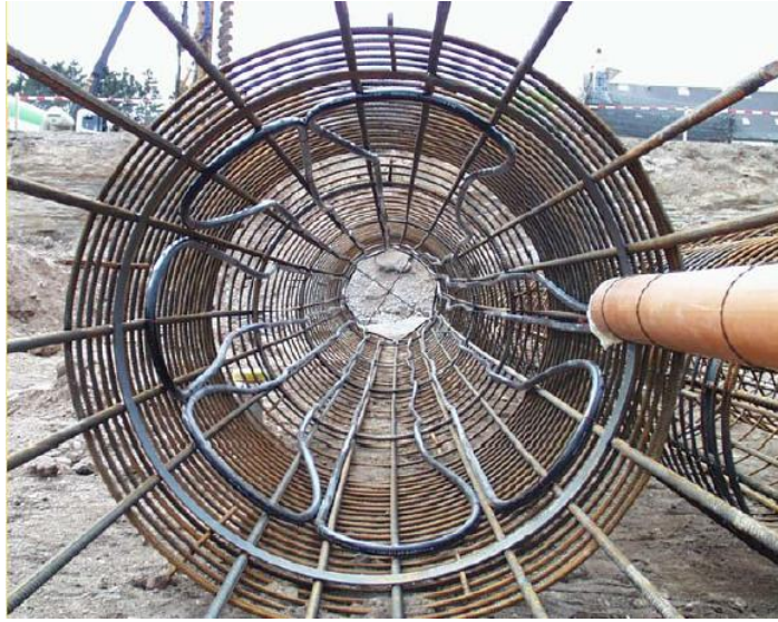
Şekil 3.4: PE boru monte edilmiş enerji kazığı donatısı.
