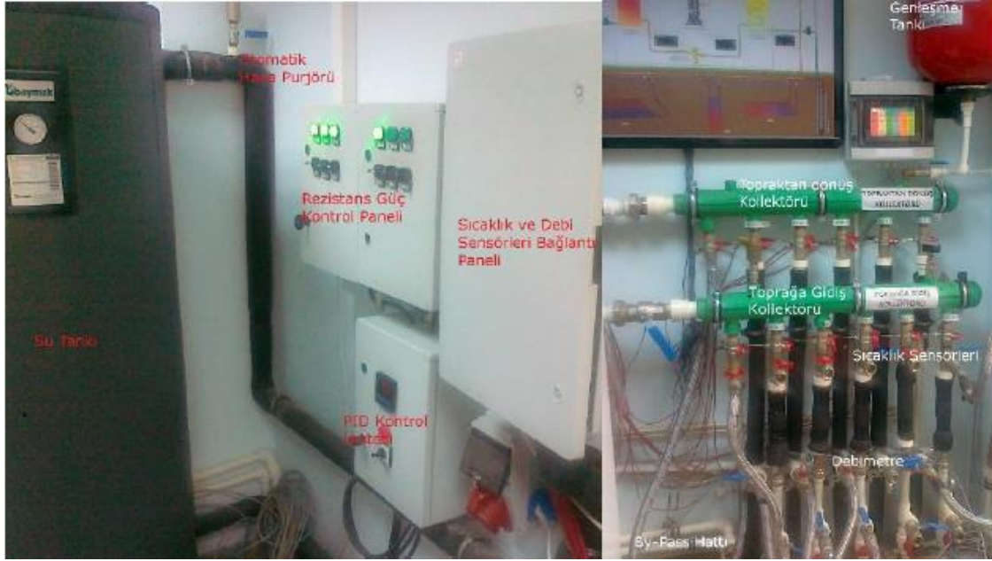
Şekil 2.13: Isıl tepki testi elemanları (Gültekin, 2014).
