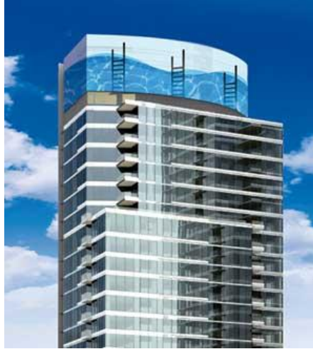
Şekil 1.12 : Ayarlı sıvı sönümleyici, One Ricon Hill, San Fransico.
