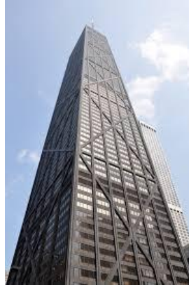
Şekil 1.8 : Tüp sistem, John Hancock Building, Chicago.
