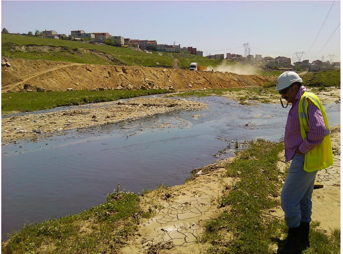
Şekil 3.4 : Haramidere dere yatağında bulunan doğalgaz boru hattı.
