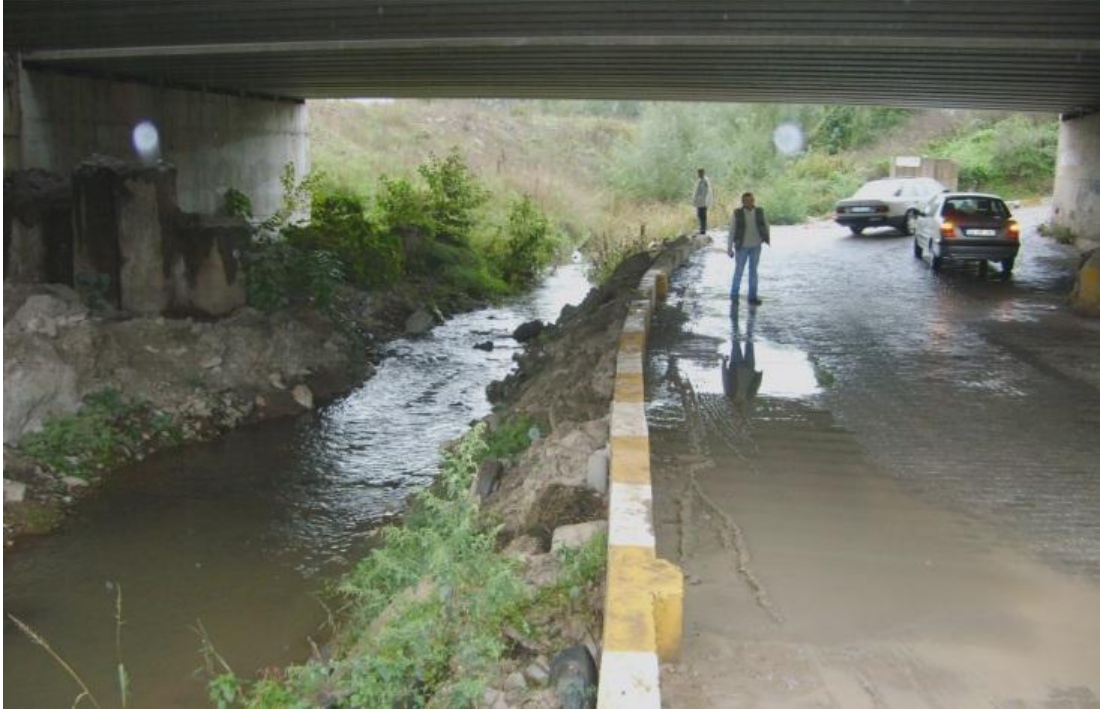
Şekil 3.26 : Dere kesitinde dolgu yapılması [38].
