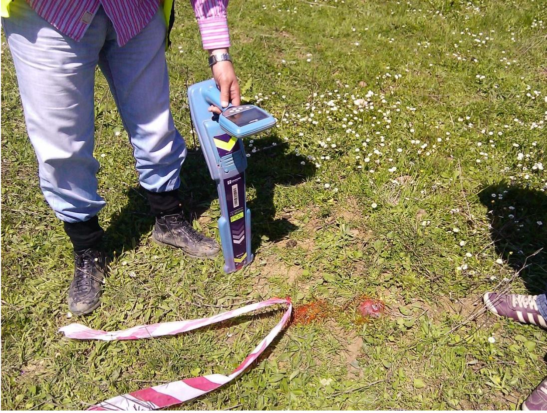
Şekil 3.5 : Haramidere dere yatağında doğalgaz boru hattı tespiti.
