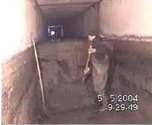
Şekil 3.9 : Ayvalıdere kapalı kesitinde biriken teressübat [7].
