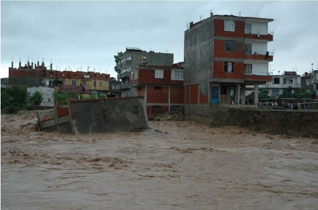
Şekil 3.29 : Dere yatağında inşa edilen binanın taşkında yıkılması [38].
