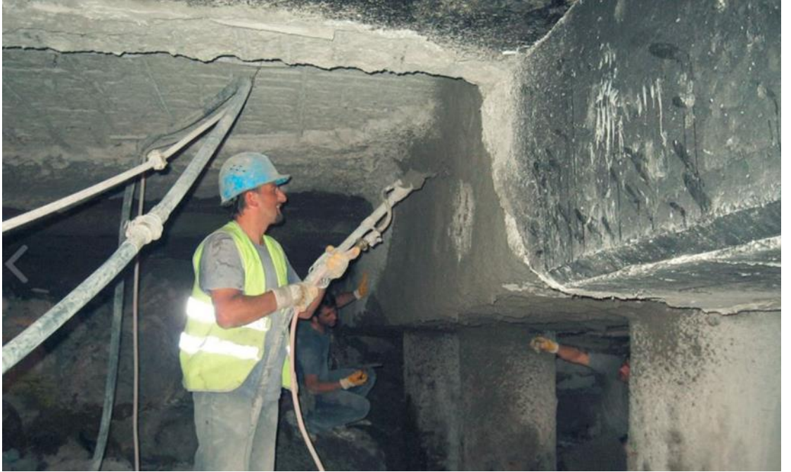
Şekil 6.16: Üst yapı onarım çalışması.
