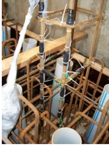
Şekil 2.5 : Ahşap kalıplar ve temel donatısı.
