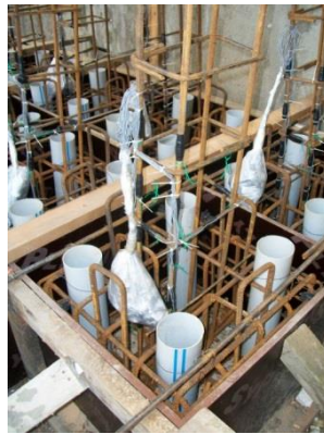
Şekil 2.7 : Kolon donatıları üzerine yapıştırılan şekildeğiştirmeölçerler.
