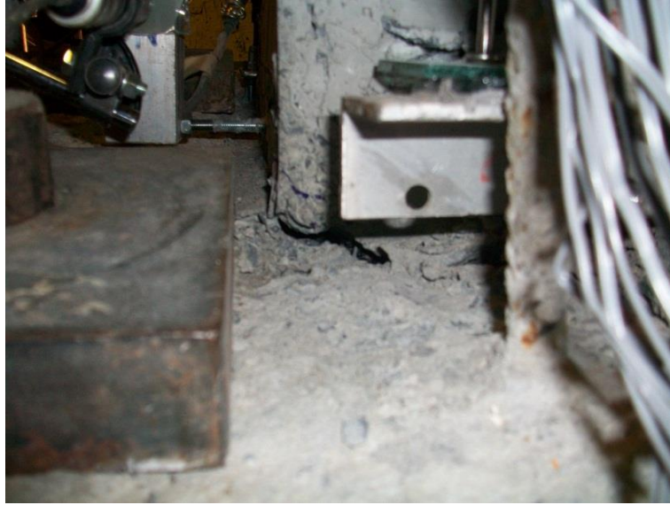
Şekil A.8 : REF numunesi % 8 itme öteleme oranında temel-kolon ayrılması görünümü.
