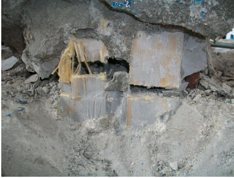
Şekil A.13 : LAM numunesi deney sonrası ankraj kontrolü-deney sonrası.
