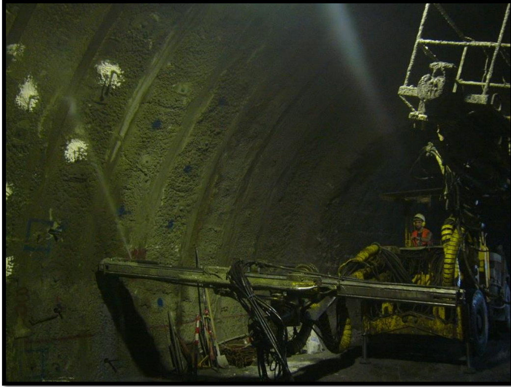
Şekil 3.8: Bulon (Kaya saplaması) delgisinin oluşturulması.
