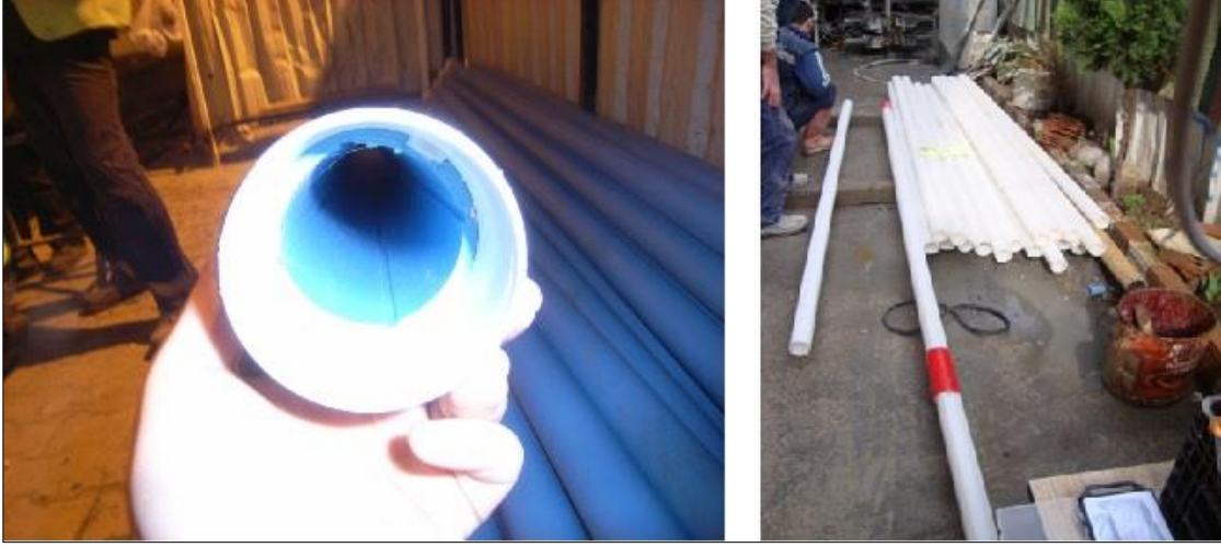
Şekil 5.4: Sirkeci istasyonuna yerleştirilen inklinometre boruları
