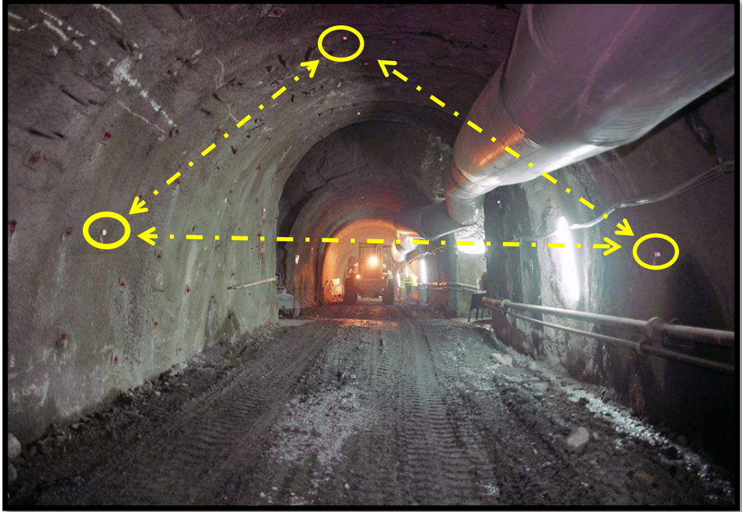
Şekil 5.7: Tünel içine yerleştirilen Konverjans noktalarına ait örnek bir uygulama.
