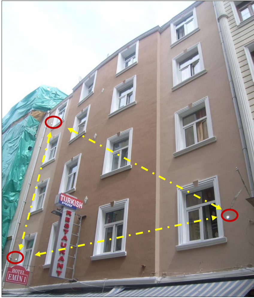
Şekil 5.2: Güzergâh üzerinde bulunan bir binada üç boyutlu gözlem için tesis edilmiş ölçüm noktalarının konumu.
