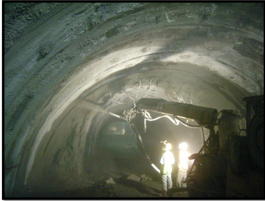
Şekil 3.7: Sirkeci İstasyonunu Pilotu Tünellerinden püskürtme beton uygulaması.
