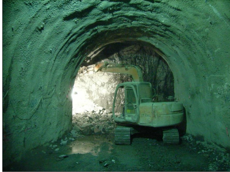
Şekil 3.5: Mekanize pilot tünel kazısına örnek bir görüntü.
