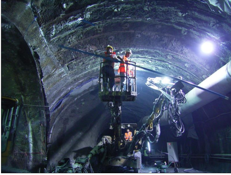
Şekil 5.16: Sirkeci İstasyon Tüneline yerleştirilen yerinde inklinometre cihazının yerleştirilmesi.
