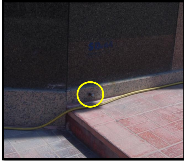
Şekil 5.1: Güzergâh üzerinde mevcut bir binaya yerleştirilen otuma bulonu.
