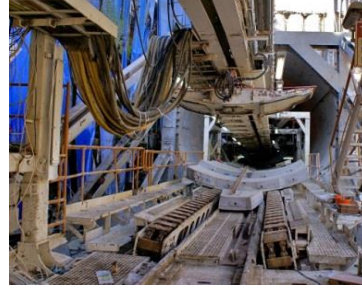
Şekil 2.4 : Tünelin segmentlerle desteklenmiş kesimi (solda), Destekleme elemanlarını tünel aynasına taşıyan bant sistemi (sağda).
