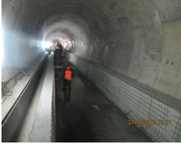
Şekil 2.4 : Tünelin segmentlerle desteklenmiş kesimi (solda), Destekleme elemanlarını tünel aynasına taşıyan bant sistemi (sağda).
