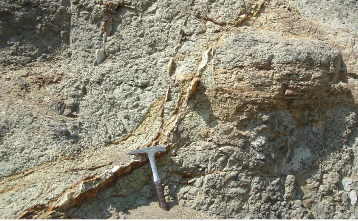
Şekil 4.5 : Çanakkale-Çan yol yarmasında çatlaklar boyunca gözlemlenen demirli alterasyon . (462175/4435016)
