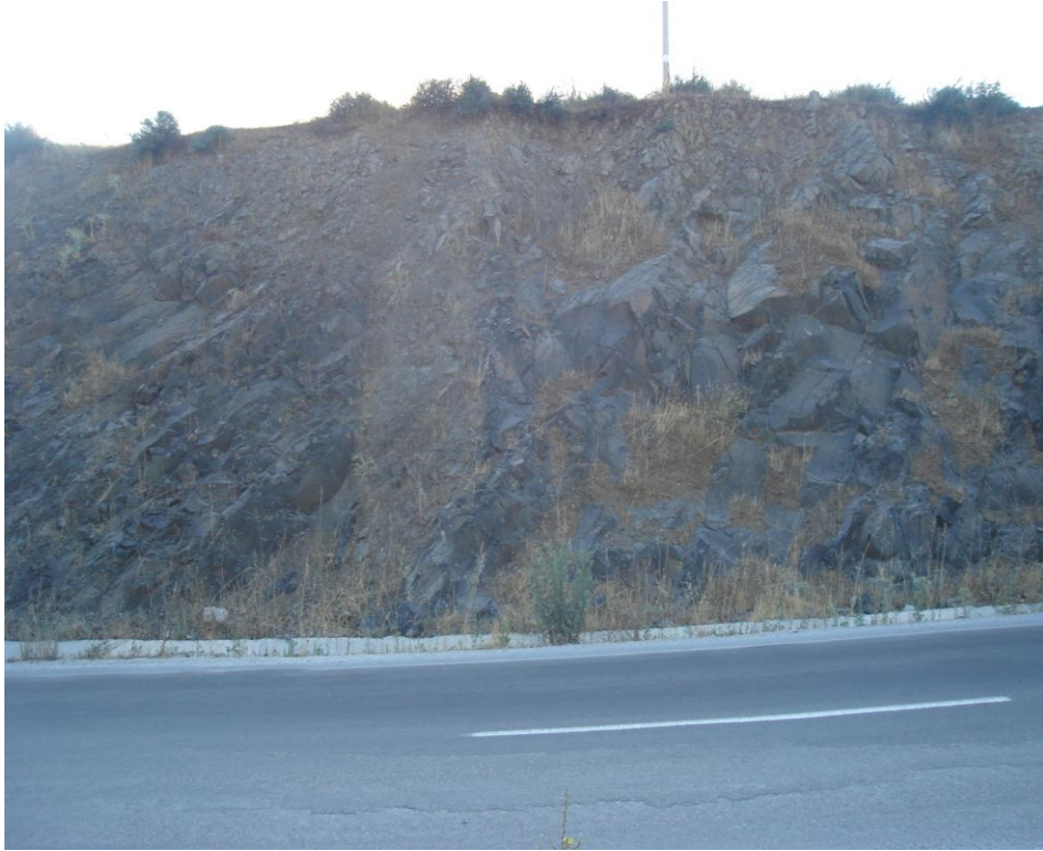
Şekil 4.4: Çan-Yenice yolu bol çatlaklı Çan volkanitleri lav akıntıları. (504678/4430101)
