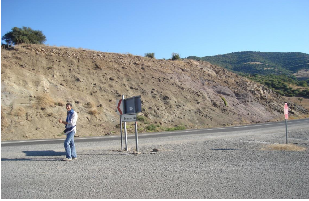
Şekil 4.15 : Bloklü tüf lav dokanağı ( Serçeler köyü civarı yol yarması).
