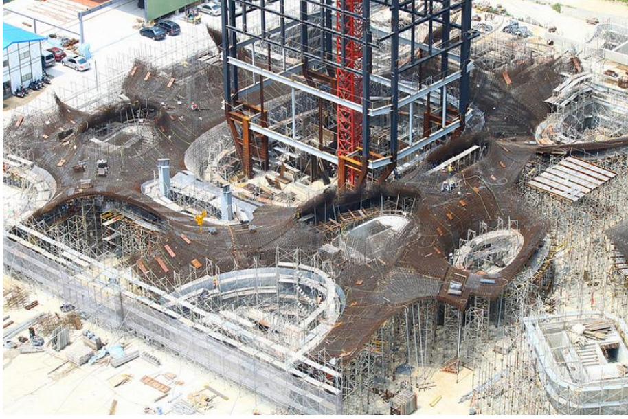
Şekil 4.34 : Yapının inşaat halinden bir fotoğraf (URL-35)
