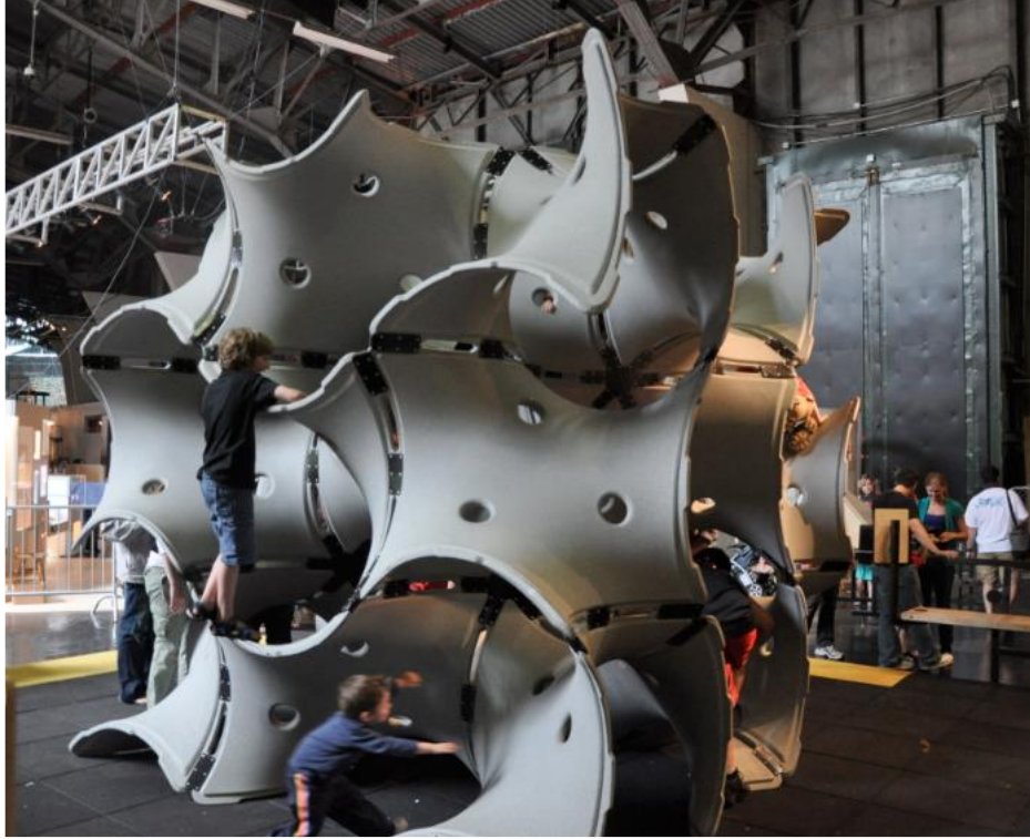
řekil 4.17 : 27 eř parçadan oluřturulan Gyroid prototipi (Dancu ve Hido, 2010)
