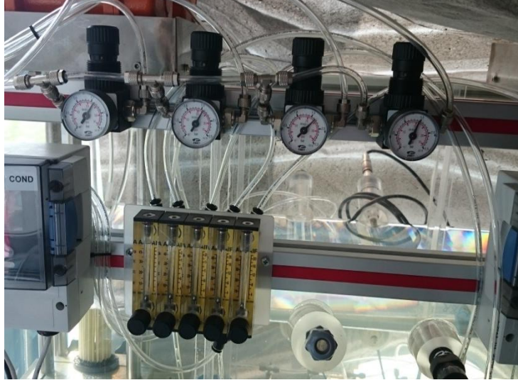
Şekil 3.4 : Havalandırma vanalarının görünümü.
