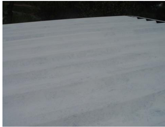
Şekil 4.22 : Supertherm uygulaması.
