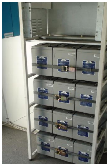
Şekil 4.18 : Akü rafı (3x4, 12 adet 6 V 155 Ah boş akü).
