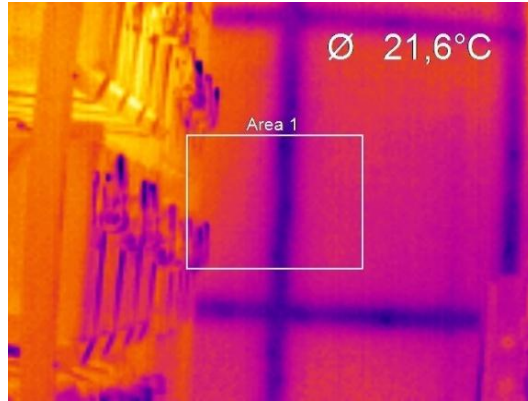
Şekil 2.5 : İçeriden duvar görüntüsü.
