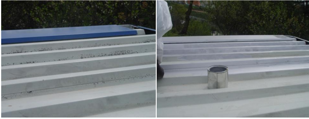
Şekil 4.21 : Paslı üst yüzey ve rustgrip uygulaması.
