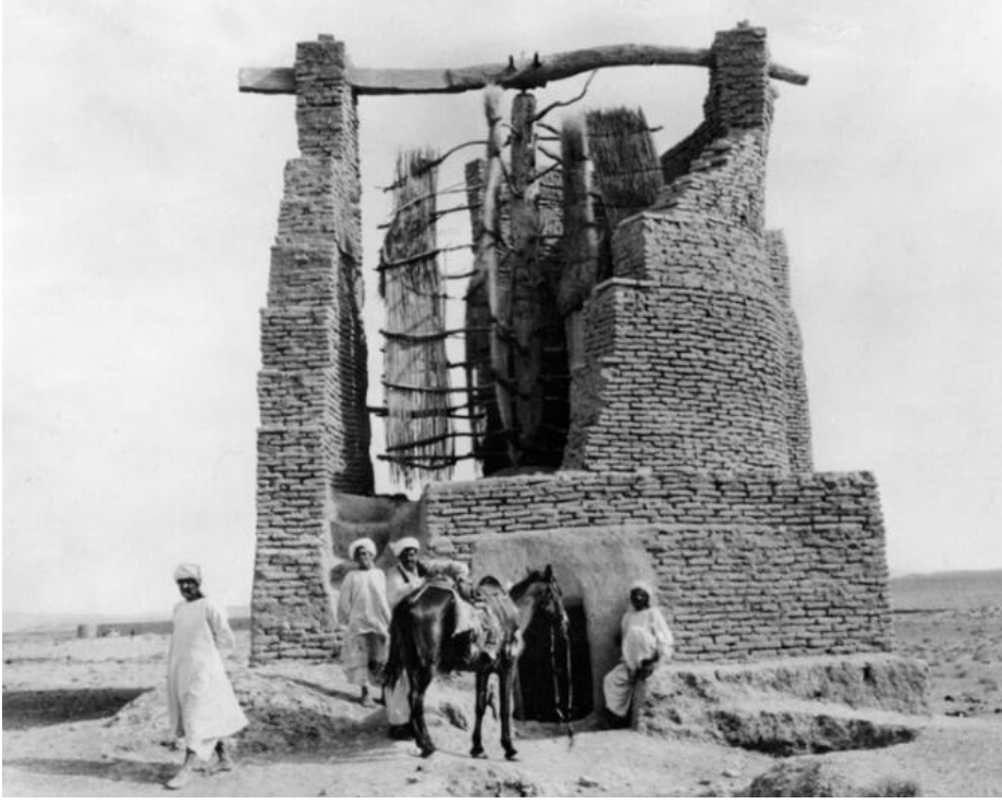
Şekil 2.10 : Afganistan'da tahıl öğütme amaçlı kullanılan düşey eksenli bir rüzgar türbini (Hau, 2006).
