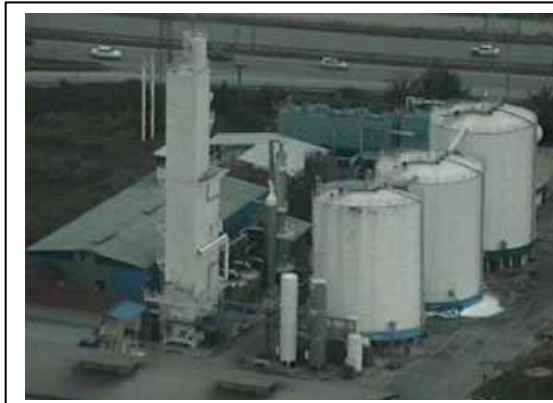
Şekil 6.2. Köseköy’de kimyasal bir tesisin ortadaki tankındaki hasar görüntüsü
