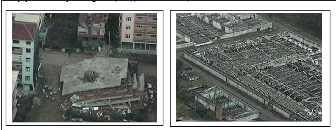
Şekil 6.1. Soldaki resimde İzmit’ de yıkılmış betonarme bir apartmanın görüntüsü
