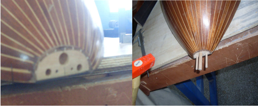
Şekil 3.50 Takoza kavelanın çakılması
