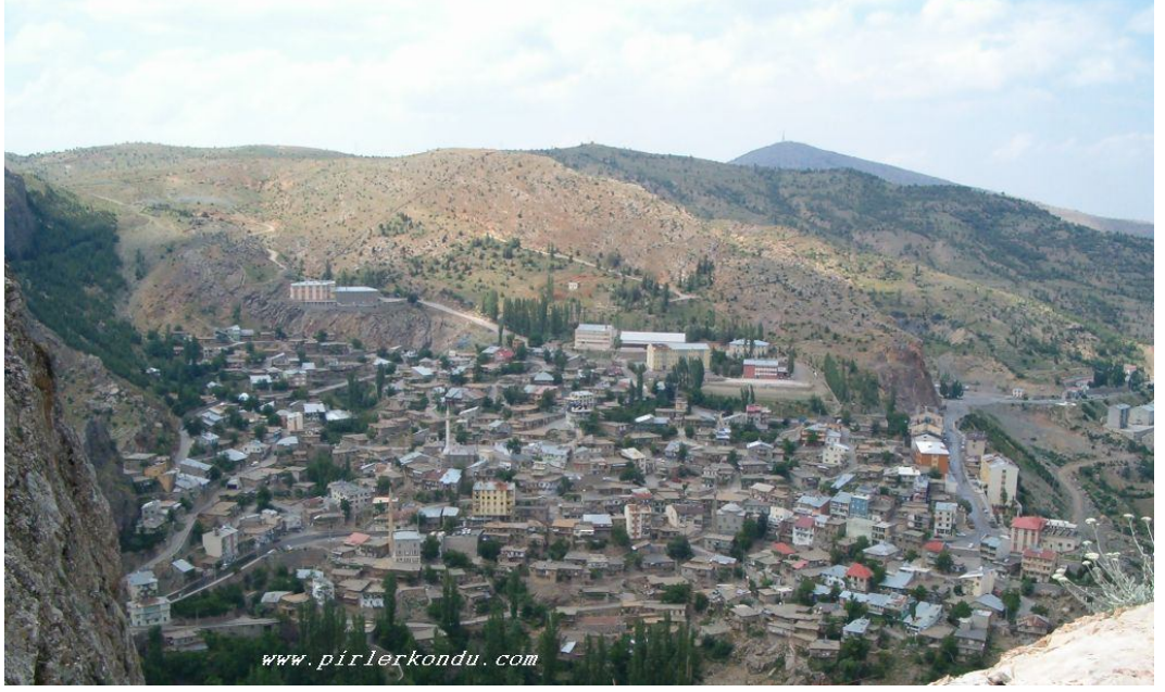
Şekil D.1: Taşkent Genel Görünüş
