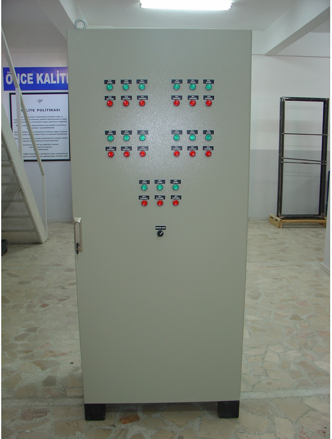
Şekil 4.2 : Gerçekleştirilen panonun önden görünümü.
