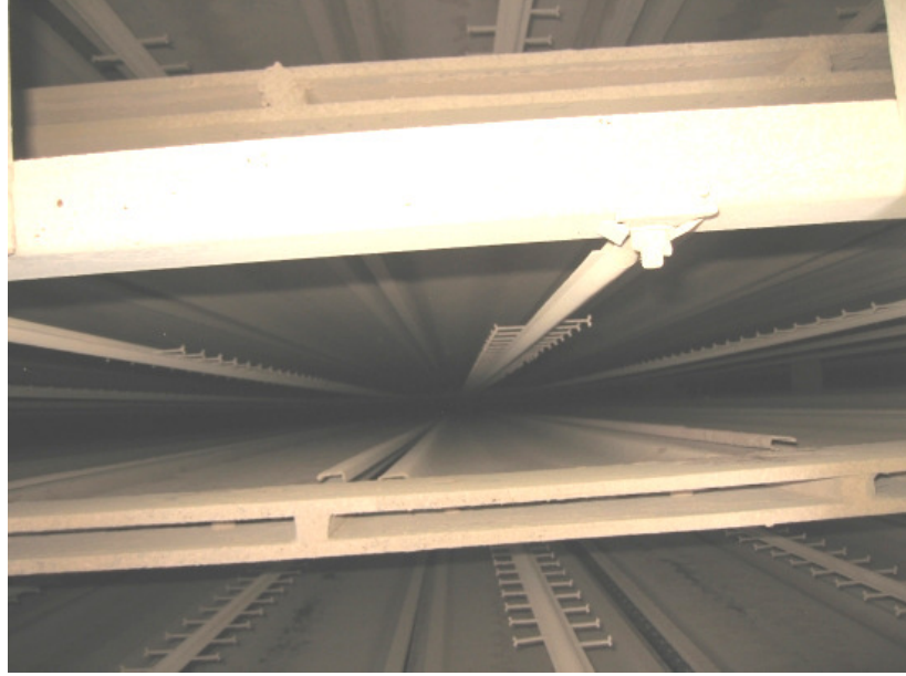
Şekil 2.10 : Korona ve toplama elektrotlarının üstten görünüşü.
