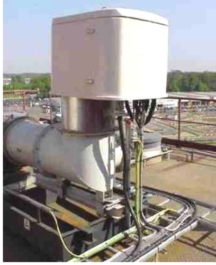
Şekil 3.5 : Yeni sisteminin elektostatik filtre üzerine kurulumu [39].
