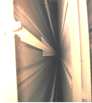
Şekil 4.1 : Korona ve toplama elektrotları.
