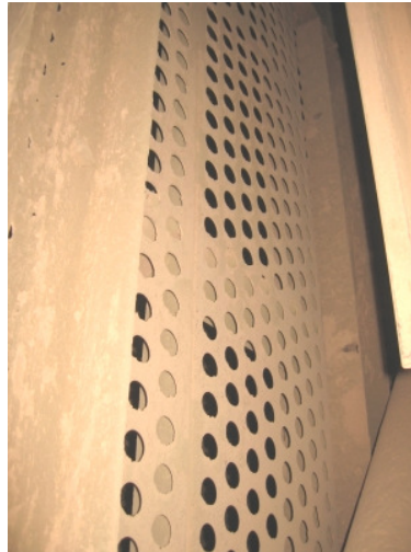
Şekil 2.18 : Elektrostatik filtre girişindeki delikli plaka.
