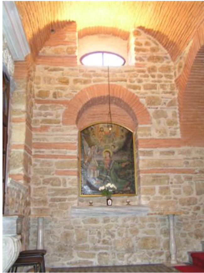
Şekil 4.73 Surp Isdepanos Kilisesi vaftiz mekânı genel görünüm
