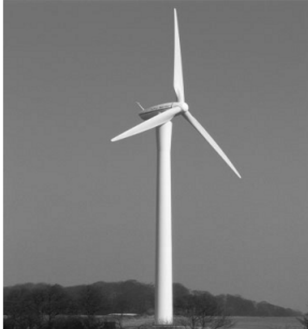
Şekil 2.5 : Yatay eksenli bir rüzgar türbininin şekli [21].
