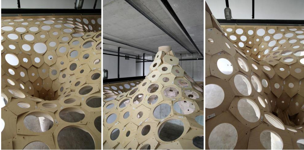
Şekil 3.92 : La Voute de LeFevre Projesinin modüllerinin birbirine bağlanması ( http://blog.archpaper.com )
