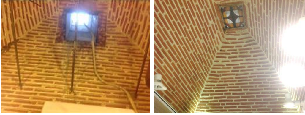
Şekil 3.25 : Bir hücre içinde bulunan hava ve aynı zamanda doğal ışık bacası ile müdahale edilmiş olan hava bacası (2013).
