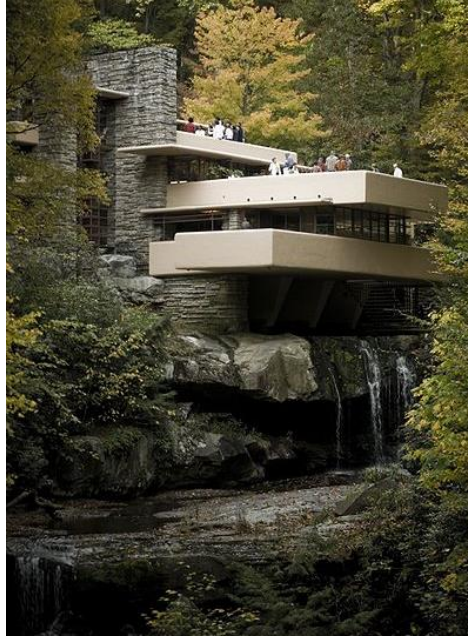
Şekil 2.32: Şelale evi dış görünümü (Url-5). Şelale ve mimari kütlenin ritimsel bütünleşmesi, doğa ve mekânın uyumu gözlemektedir.
